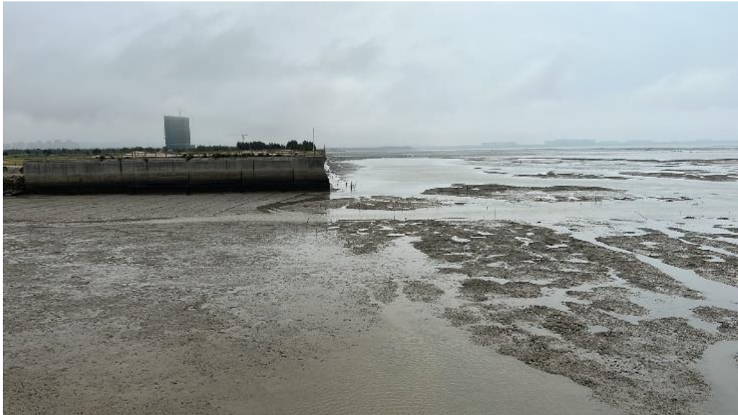
图 5.1-7 本项目 1 号桥跨欧厝东海堤现状图
