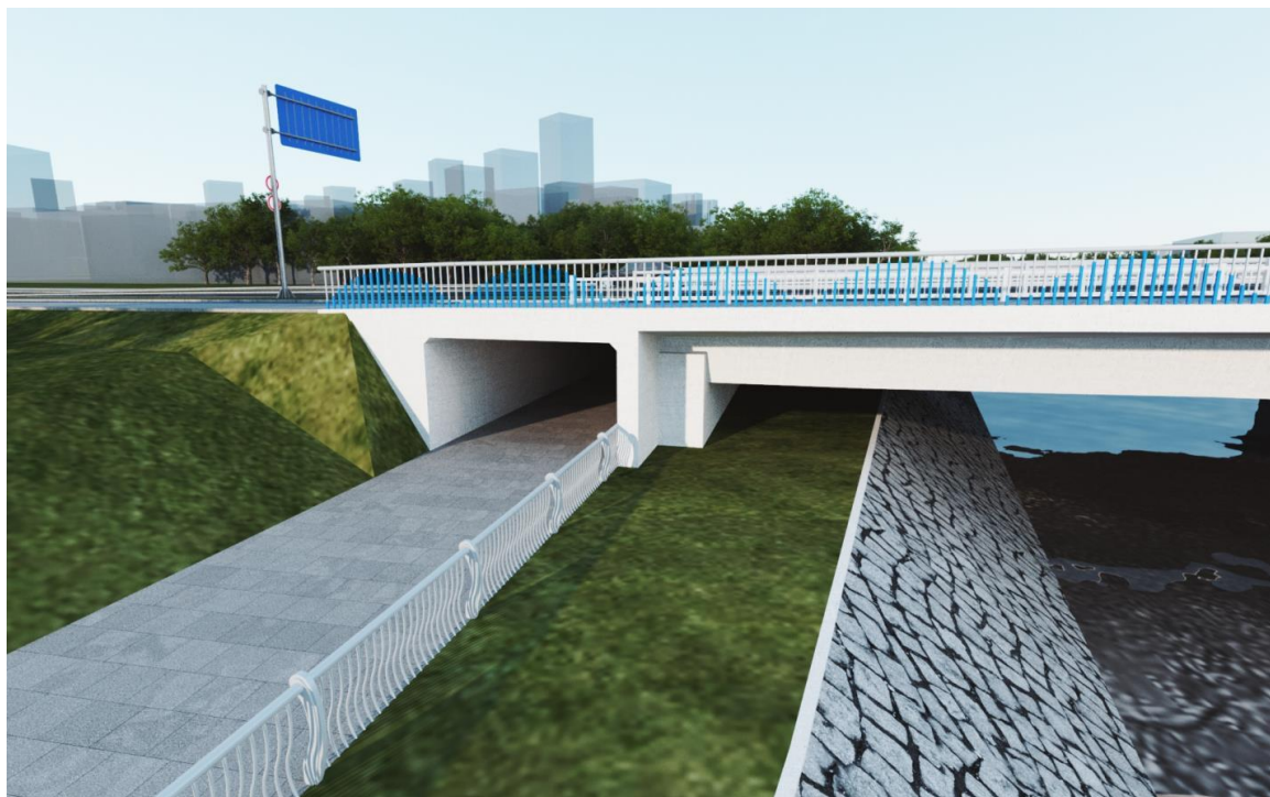
图 2.2-33 桥台结合人行通道设计效果图
