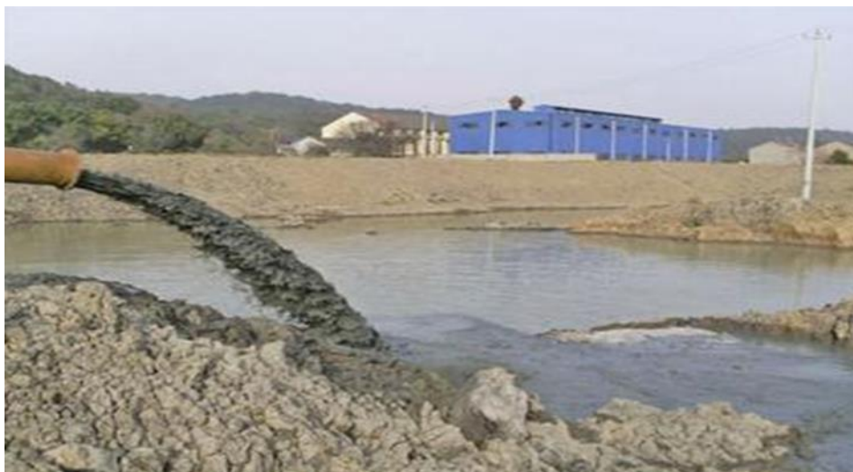
图 2.3-6 自然脱水技术示意图
